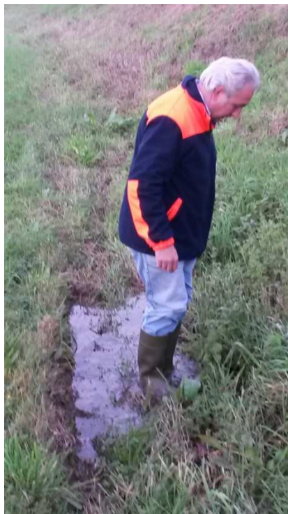
Figura 2-15: Venuta d'acqua al piede del rilevato arginale a lato campagna.
